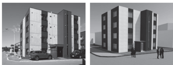
図2-2 北広島市共栄町1丁目マンション 左 完成写真 右 コンペにて学生が制作したイメージパース
