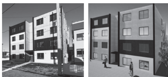
図2-4 北広島市共栄町4丁目マンション 左 完成写真 右 コンペにて学生が制作したイメージパース
